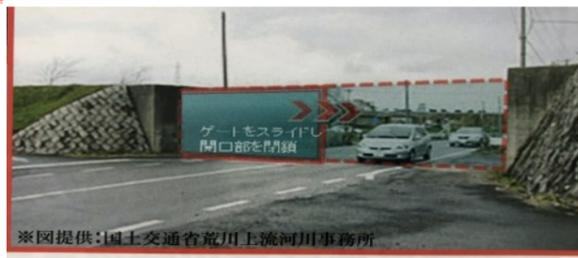
治水橋の道路部分に陸閘(増水時に塞ぐゲート)を設置し、洪水をせき止める対策を行います。今年度より着工予定です。
